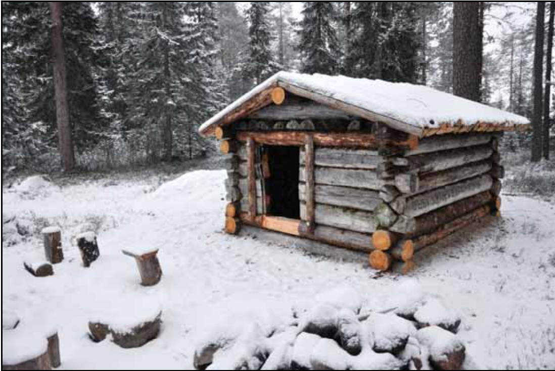
Kuva: 7633:20. Rimpisen sauna. Kunnostettu kämppä luoteesta.
