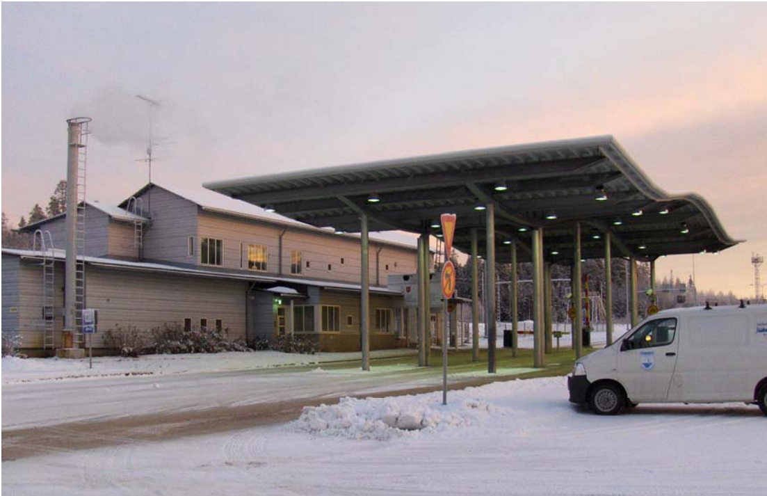
Kuva 2. Vartiuksen tulli- ja raja-asema on valmistunut vuonna 1995.
