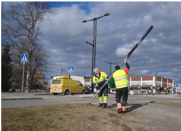
Kuva 23: Liikennemerkkin irrotus.
