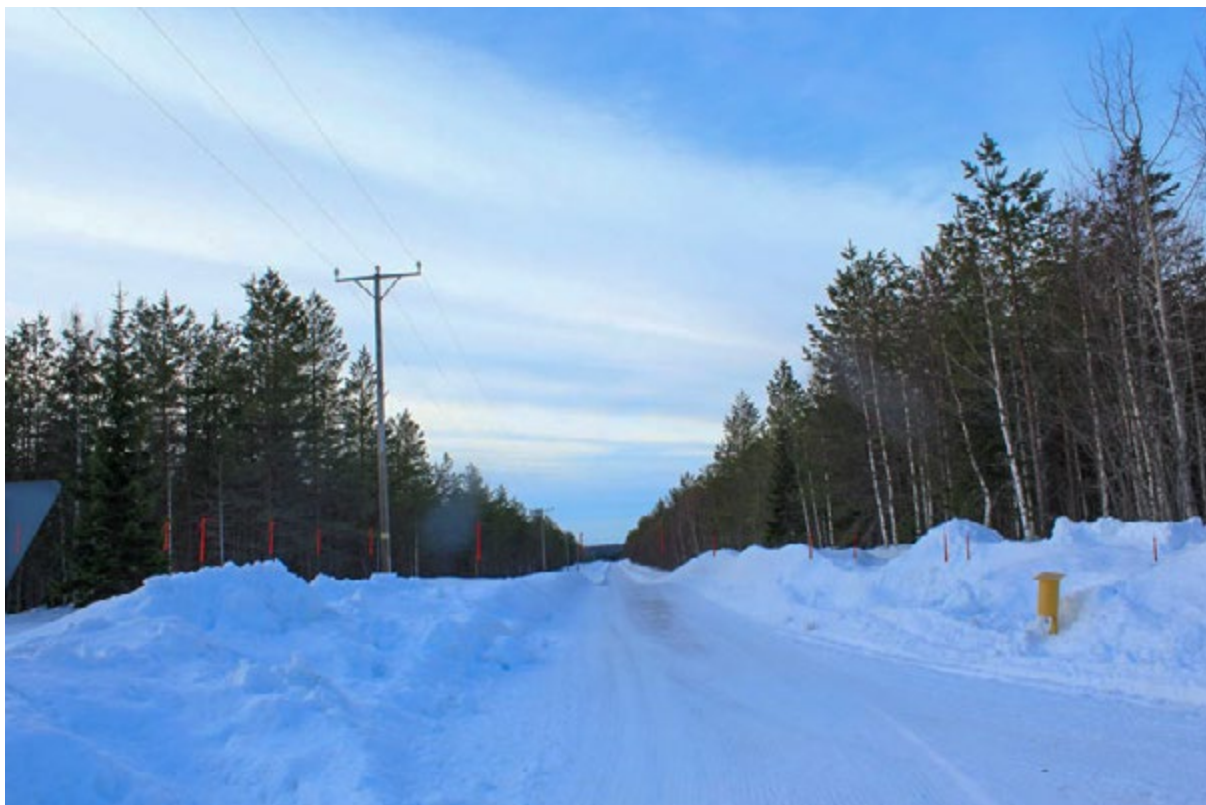
Kuva Somerentien ja Väliahontien risteyksestä. Pohjakuva 11.2.2015 14:06. Canon 560 D Polttoväli 29 mm (kinofilm), 1/25 s, F 14.05. Voimalaitokset (punaisella) jäävät pääosin vasemmalle puuston taakse. Tien päässä näkyy yksi voimalaitos.
