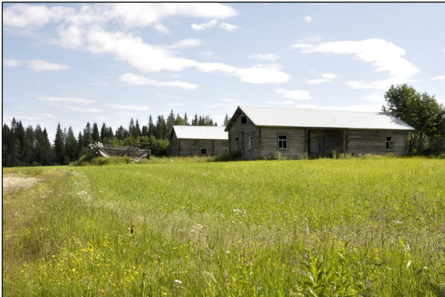
Kuva 17. Kyntölä tilan rakennuksia.
