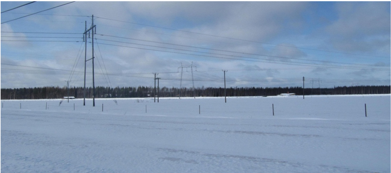
Maaselänkangas-Lammaslamminkangas kuva 1 ilman tuulivoimaloita.
